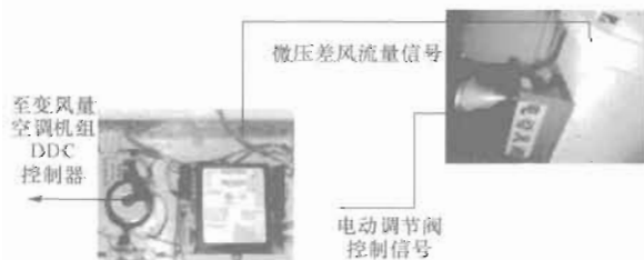
图 3.8 VAV 系统变风量末端装置
