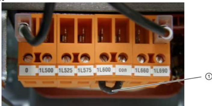
图 4-11 风机变压器的连接端子 (2 AC 500至690 V)
