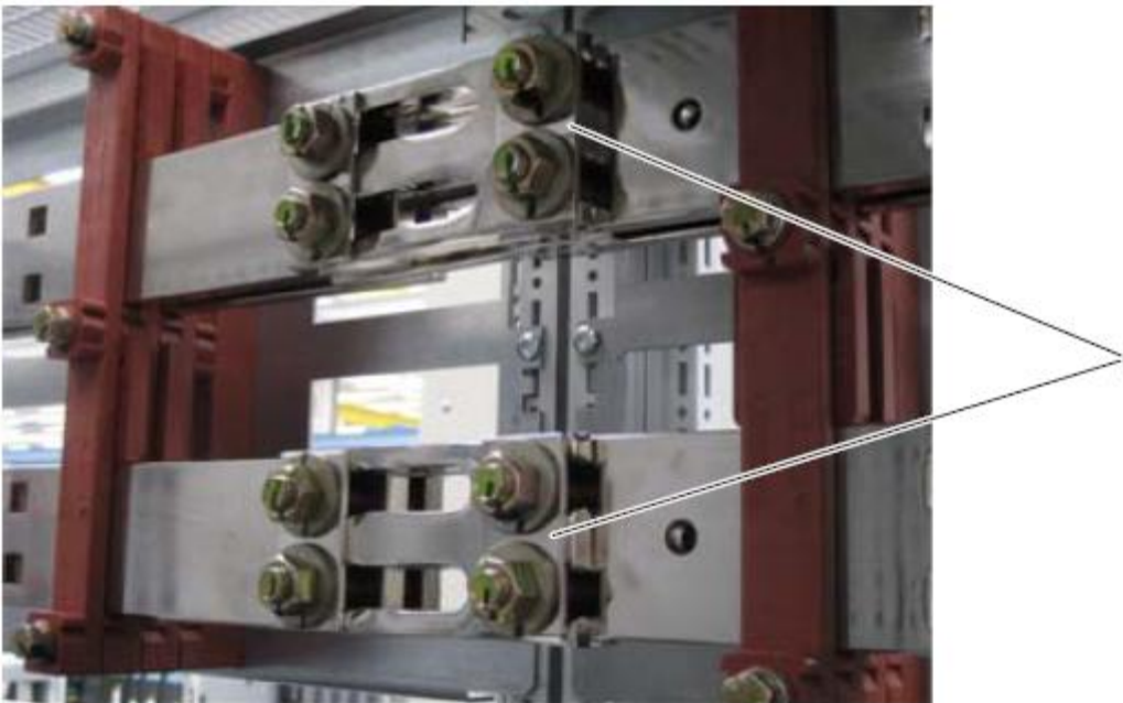
图 4-4 机柜设备并柜时的直流母线连接
