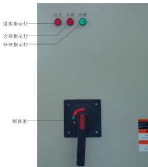
图 4-1 小于 800kW（含）配电柜人机界面
