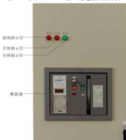
图 4-2 大于 1000kW（含）配电柜人机界面
